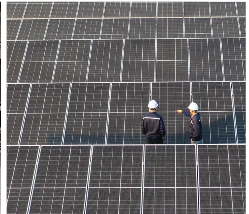
Solaranlage von Bucher Emhart Glass, Zibo
